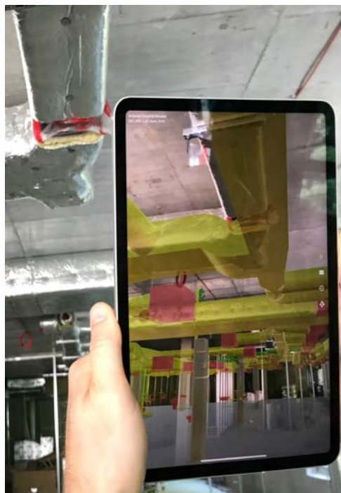
Fot. Zgłoszenie z budowy
