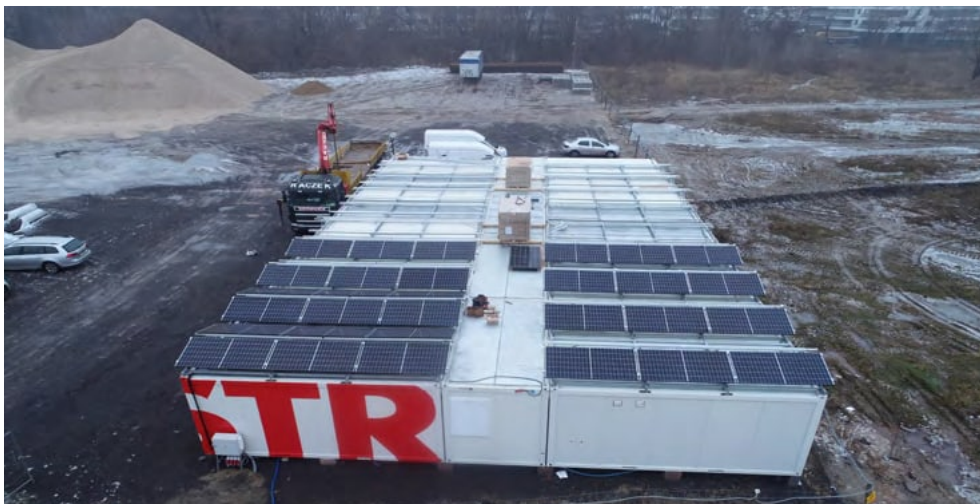
Fot. Kontenery zaplecza budowy tramwaju na ul. Kasprzaka w Warszawie
