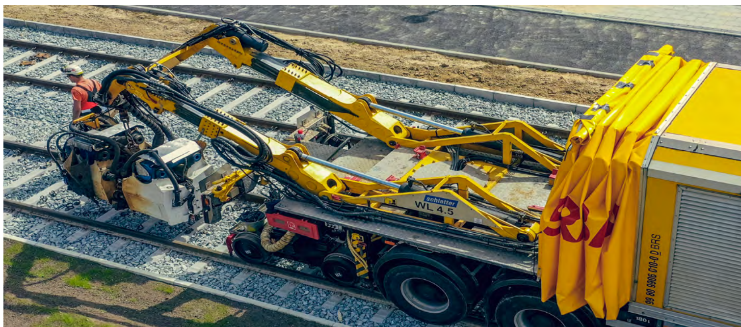
Fot. AMS 100 Supra Flex w trakcie prac torowych
