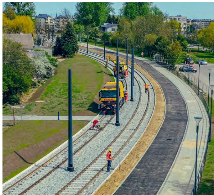
Fot. Torowisko na ul. Nowej Warszawskiej
